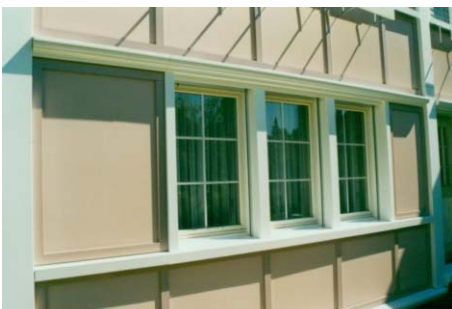
Zarge mit Sturz- und Sockelprofil durchlaufend
