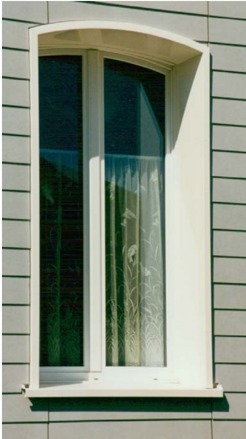
Fensterzarge mit Rundbogen
