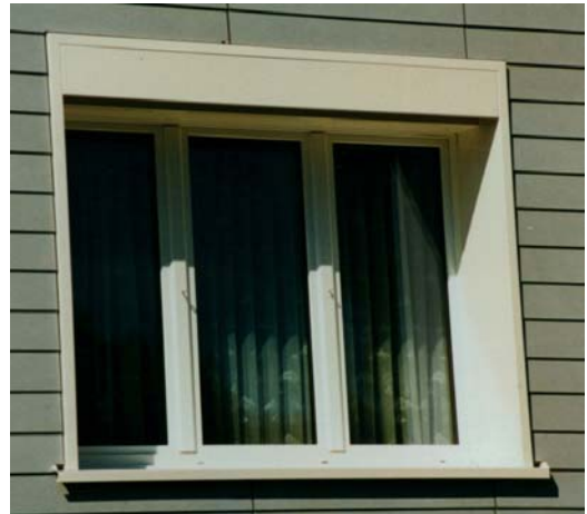
Fensterzarge mit Storenkasten
