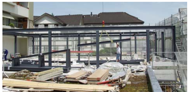
stellen des Stahlbaus
