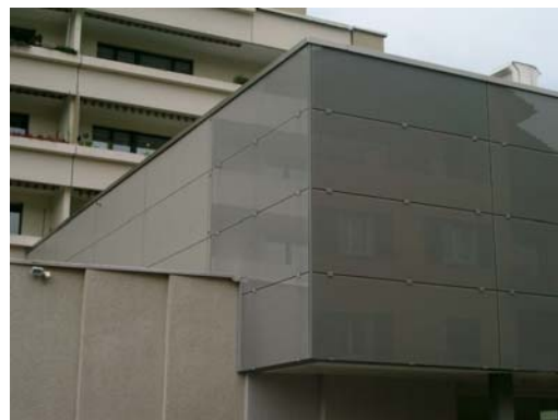
Übergang Glas- auf Eternitfassade
